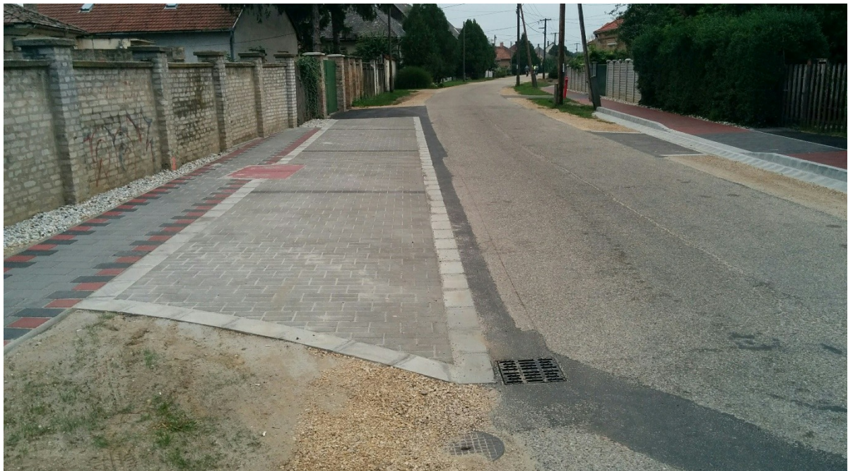
2. kép Tét, kórház melletti balesetveszélyes járdaszakasz és parkoló kiépítése
