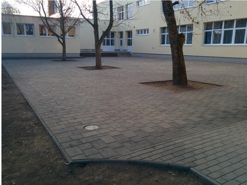
6. kép Tét, balesetveszélyes iskolaudvar megszüntetése, térkővel történő kiépítése
